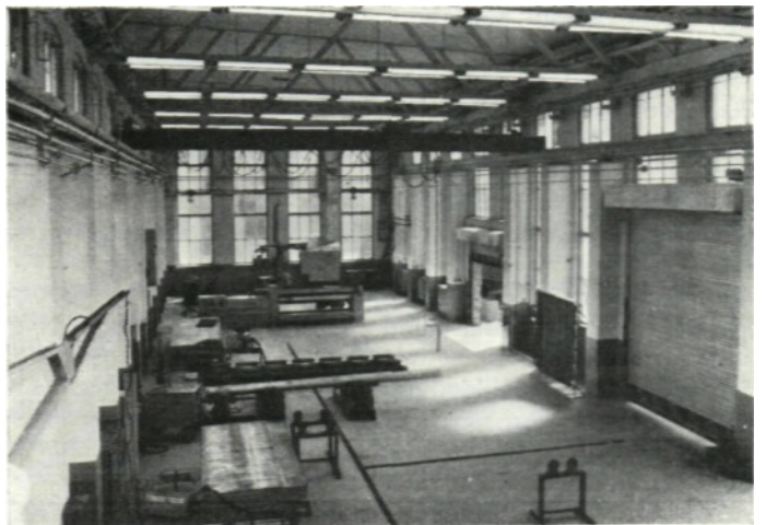
Halle 2 Werk I Vorbereitete Arbeitsstrecke für K-Produktion (austenitische Werkstoffe) 1986
