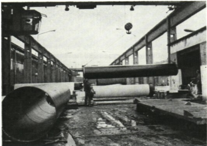
Krananlage Werk II Zuführung von Rohren zur Bituminierung
