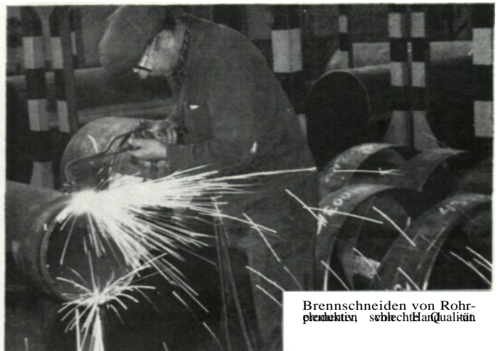
Brennschneiden von Rohrelementen von Hand - unproduktiv, schlechte Qualität
